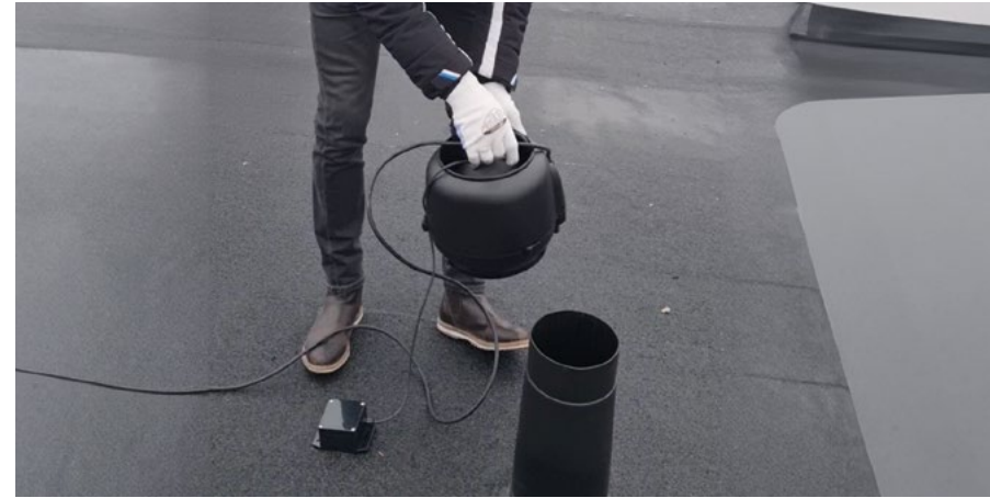
VILPE Sense ECo -huippuimurin jälkiasennus VILPE Alipai -tuulettimen päälle.
