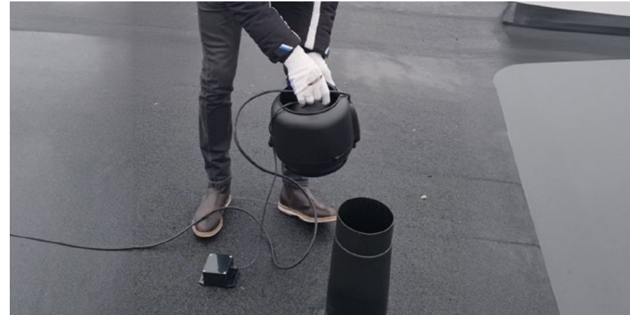
VILPE Sense ECo-takfläkt installerad i efterhand på en VILPE Alipai-undertrycksavluftare.
