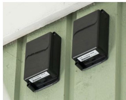
Till vänster: VILPE Sense-utomhusgivarna fästa på ytterväggen. Bostadsbolaget har två VILPE Sense-system och därmed två utomhusgivare. Till höger: VILPE Sense-inomhusgivare i kryppgrunden.
