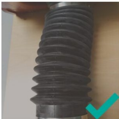
Правильный монтаж. Гофротруба соединяет несоосный вентиляционный выход канализации с канализационным стояком.
