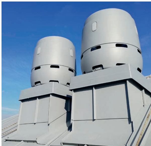
Hopeanharmaat VILPE 315/400S FLOW -ulospuhallushajottimet asennettuina kaltevalla katolla. Kuvan läpiviennit ovat asiakkaan rakentamat.
