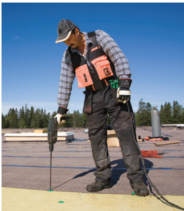
Монтаж на битумной кровле с помощью креплений Croco с регулируемым шурупом.
