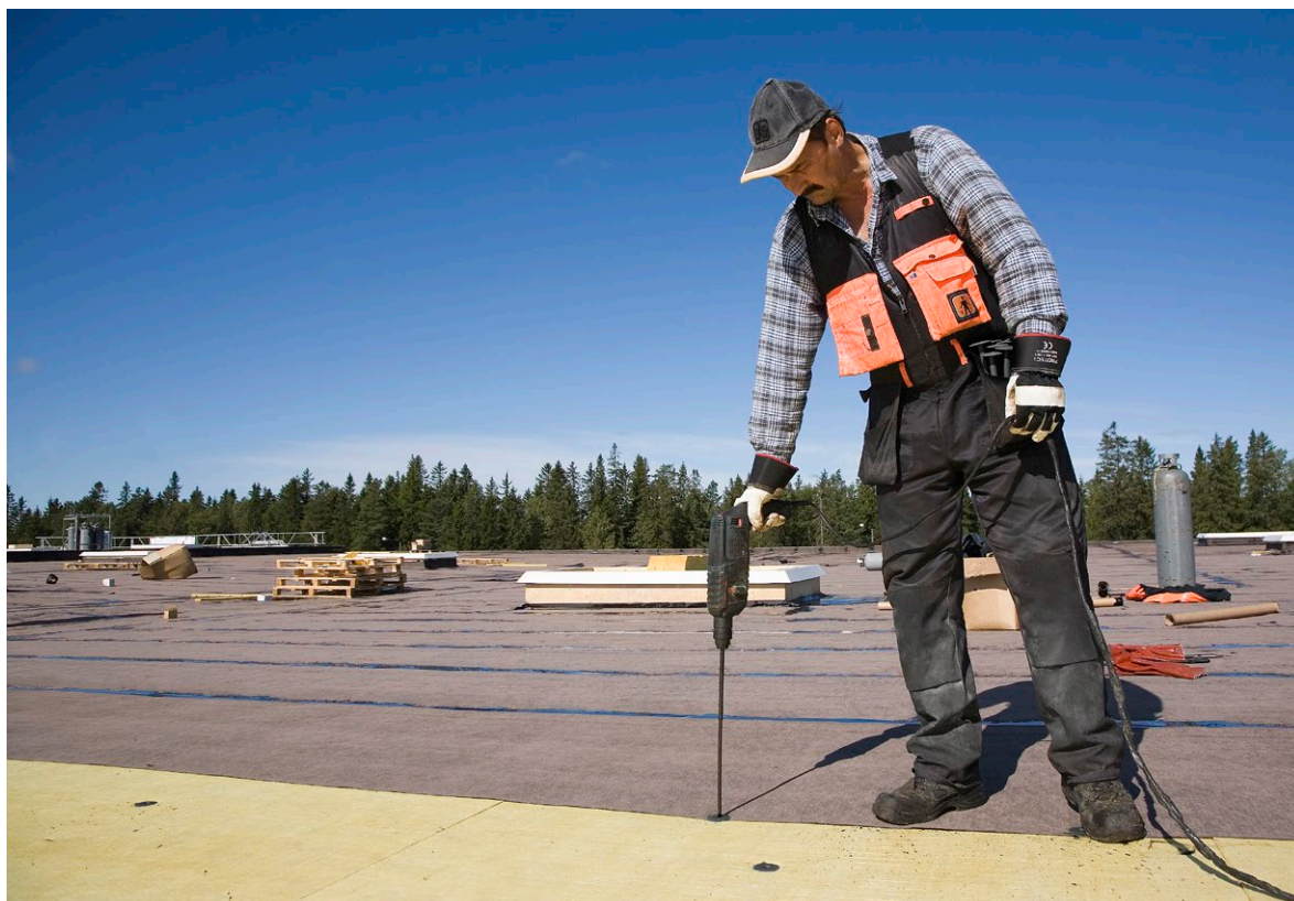
Montaż na dachu bitumicznym z użyciem łączników Croco.
