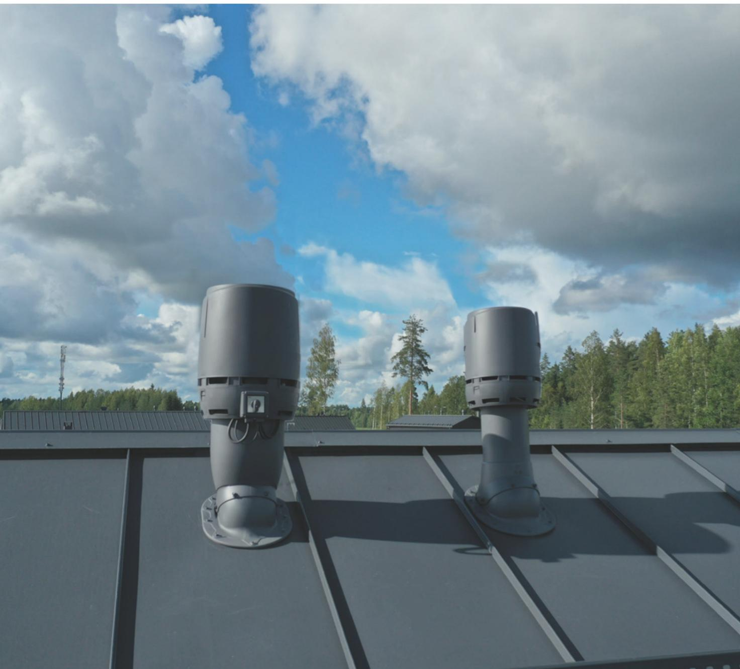
Вентилятор является ключевым компонентом в системе VILPE®. Тихая кухня и его установка гарантирует отличную вентиляцию помещения кухни. Конструкция вентилятора отличается лёгкостью и прочностью. Внешний корпус изготовлен из высококачественного полипропилена, не подверженного коррозии, устойчивого к воздействию ультрафиолета и погодных условий.
