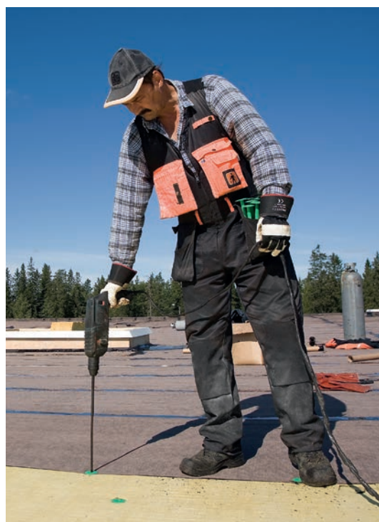
Montering av ett papptak med VILPE Croco A/B-infästningar.
